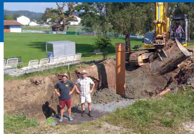
Mitglieder des FC Unteriglbach e. V. (Gemeinde Ortenburg) beim Einbau der im Rahmen des Regionalbudgets der ILE Klosterwinkel geförderten Regenwassernutzungsanlage
