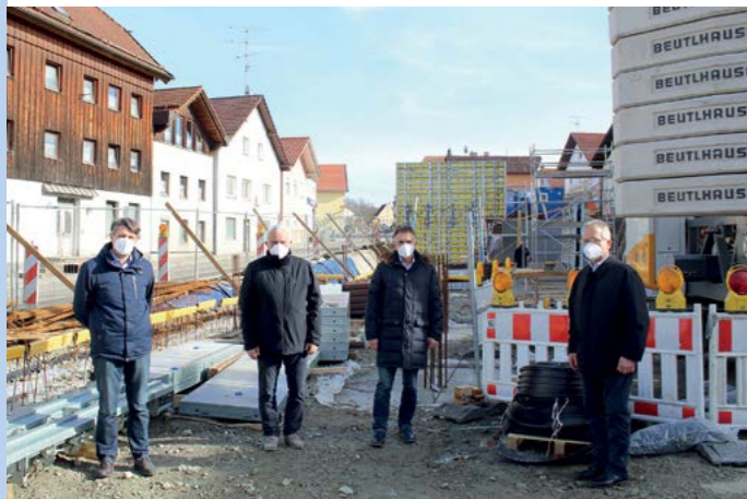
Die Herren informierten sich bei einer Begehung über den Baufortschritt am Parkdeck Unterer Markt
