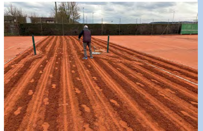
Die Oberschicht des Tenniscourts wurde abgefräst
