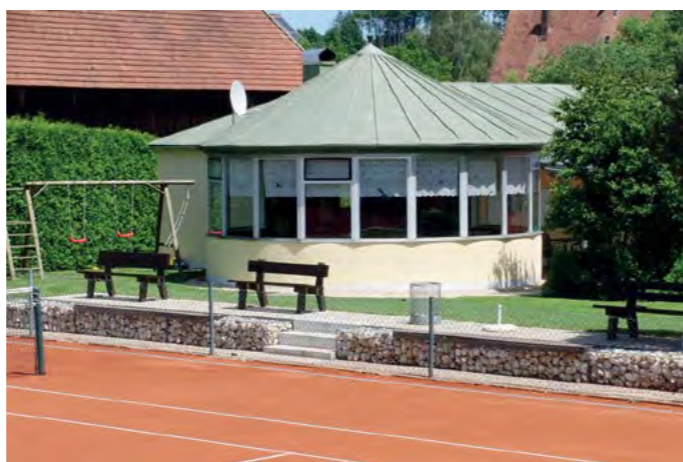
Clubhaus im unsanierten Zustand
