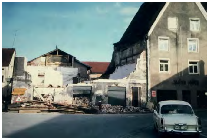
Abriss des linken Gebäudeteils in den 1960er Jahren
