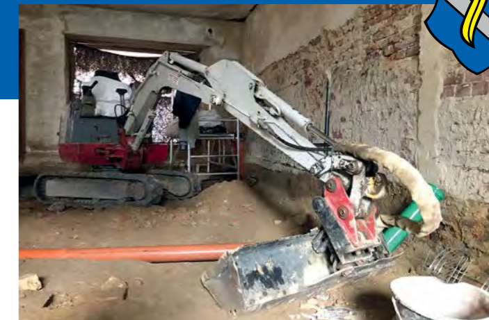
Grundlegend saniert – im wahrsten Sinne des Wortes – wurde im „Metz-Haus“ im oberen Bereich des Marktplatzes
