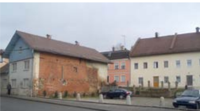
Die Vorher-Ansicht des Unterer Markts im Bereich des Parkdecks
