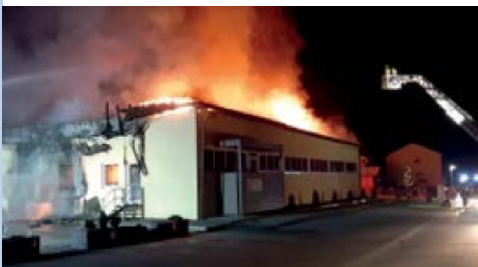
Der verheerende Brand Ende 2019 hat das Hallenbad fast komplett zerstört und unbenutzbar gemacht
