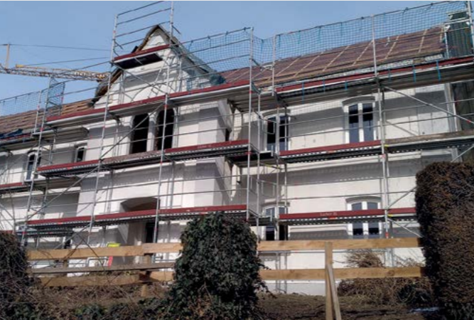
(oben) Bei der Südansicht ist deutlich zu erkennen: Die neuen Fenster im Hauptgebäude sind bereits eingesetzt. Das Fenster der Kapelle mit farbigem Glas ist noch in Arbeit.
