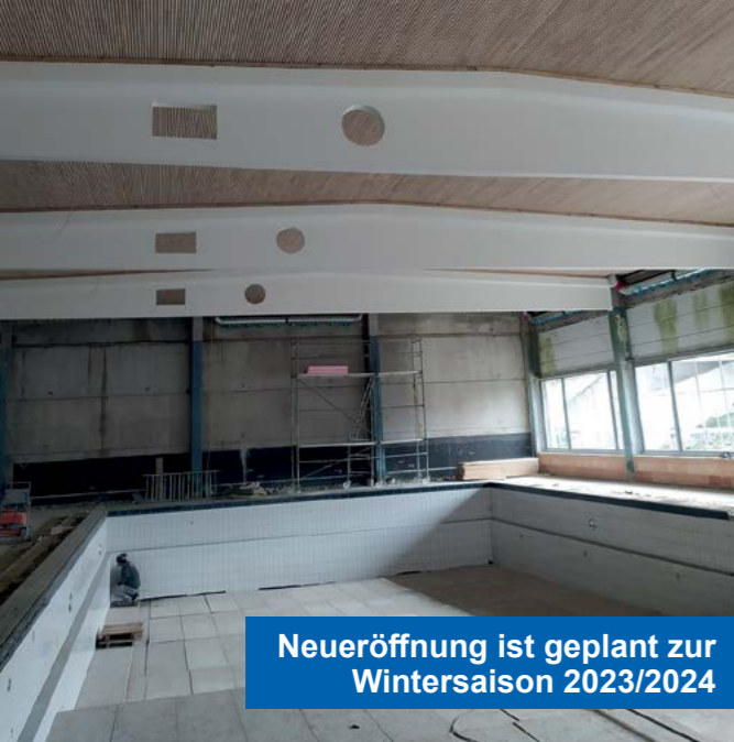
(oben) Die zukünftige Optik der Schwimmhalle ist schon zu erahnen. An der Decke ist eine moderne Holzverkleidung eingezogen worden, die Binder sind bereits saniert und passen in strahlendem Weiß zum hellen Farbkonzept Bilder Stand Anfang März
